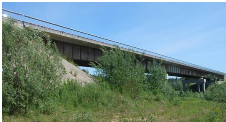
Рисунок 1. Общий вид моста через реку Малая Кожва (составлено авторами)
